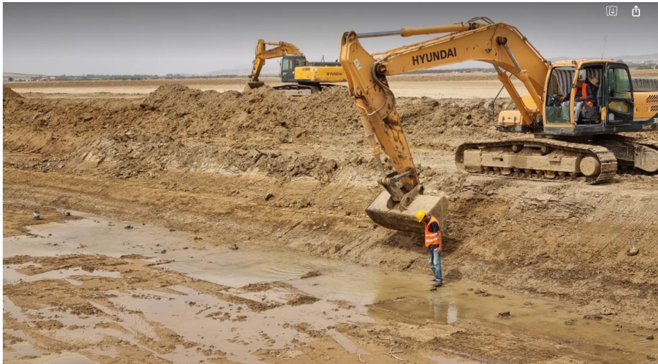
Travaux de curage de cours d'eau, Projet de protection contre les inondations de la Medjerda (Source DGBGTH)
