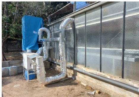
La serre expérimentale de l'INRGREF avec le nouveau dispositif de dissipation thermique aux côtés du système d'absorption
