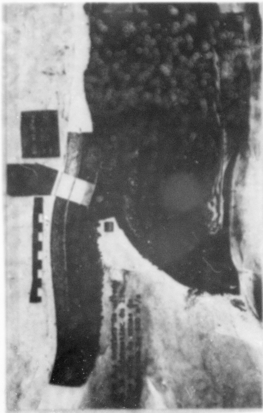
Photo 28: Etat du revêtement en perré et du fond mobile après une crue du Bou Heurtma de 900 m 3 /s
