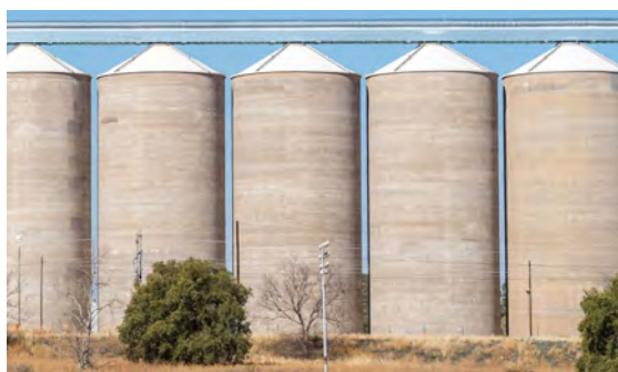
Photo 22 : Silos en béton
