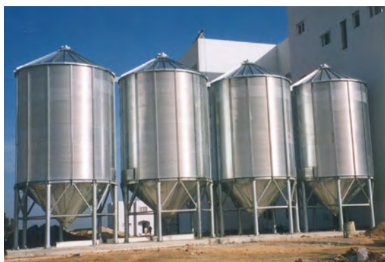
Photo 21 : Silos en Métal
