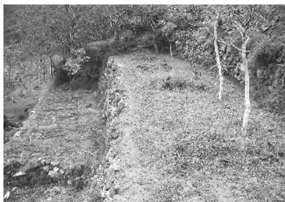
Photo 2 : Murettes antiérosives traditionnelles au Maroc (haut-Atlas), avec terrasses horizontales
