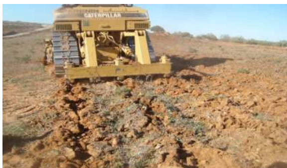
Photo 3 : Confection d'un fossé de déviation avec Ripper
