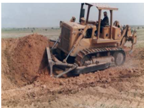
Photo 2 et 3 : Phases de mise en œuvre (bourellet et canal), Secteur à faible pente < à 10% et sols à tendance de texture sableuse : confection d'un réseau de banquette avec des engins lourds, construction du bourellet en haut, ripage du fossé ou canal vers le bas, Mtimet 2003
