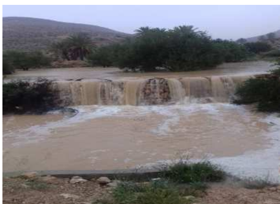
Photo 3 : Passage d'un violent orage, observer le ruissellement et la charge solide passant par le déversoir central de la tabia, MARH 2013
