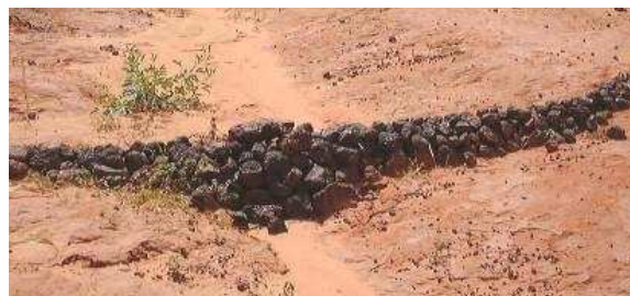
Photo 3 : Seuil de simple empierrage dans une petite ravine, intégré dans un cordon de pierre protégeant le parcellaire dans son ensemble
