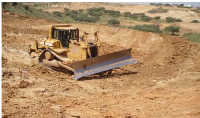
Photo 5 : Réseau de banquettes sur des petites exploitations et implantation du bourrelet et de l'impluvium (sol limono-calcaire) à observer le tassement au niveau de la plateforme (collecte de l'eau du ruissellement), Mtimet 2008
