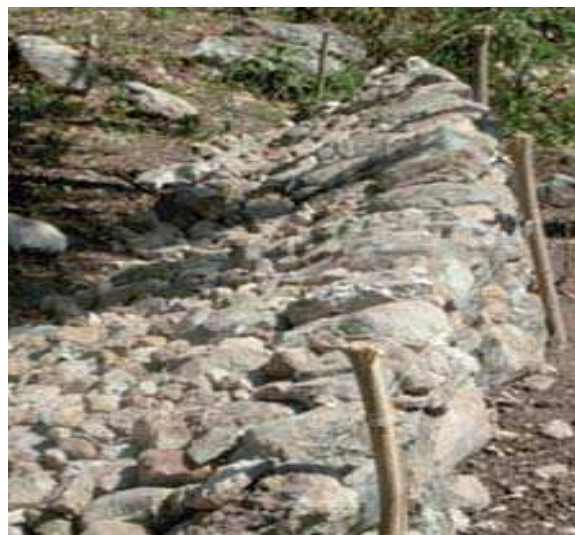
Photo 3 : MPS en cours de construction
