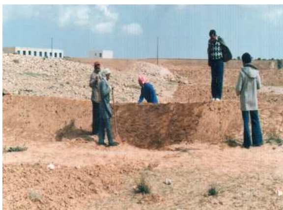
Photo 4 : Construction d'une tabia expérimentale manuelle compactée avec la margine, en zone de piedmont, Mtimet 1992
