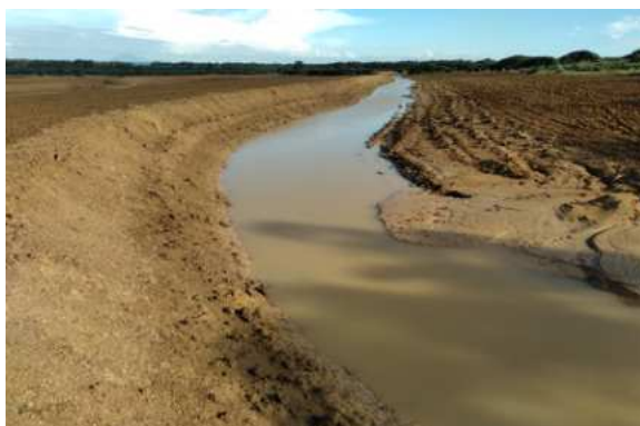
Photo 1 : Fossé de déviation des eaux ruisselées de l'amont (terrain en faible pente) pour protéger les terrains de l'aval, RMTA 2021
