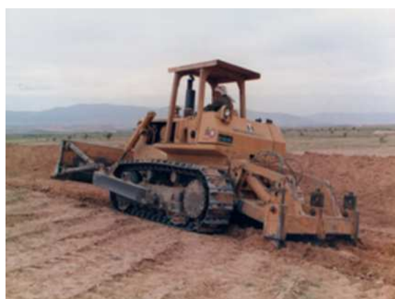
Photo 2 et 3 : Phases de mise en œuvre (bourellet et canal), Secteur à faible pente < à 10% et sols à tendance de texture sableuse : confection d'un réseau de banquette avec des engins lourds, construction du bourellet en haut, ripage du fossé ou canal vers le bas, Mtimet 2003
