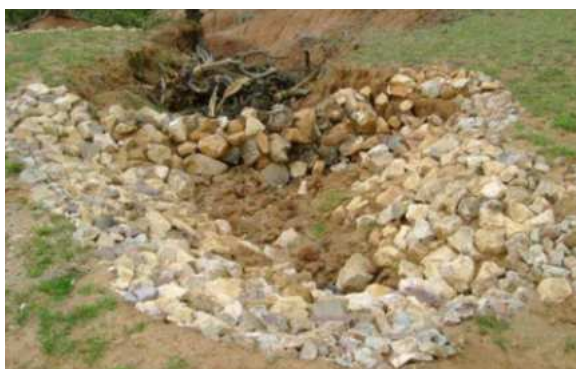
Photo 2 : Empierrage d'une tête de ravine
