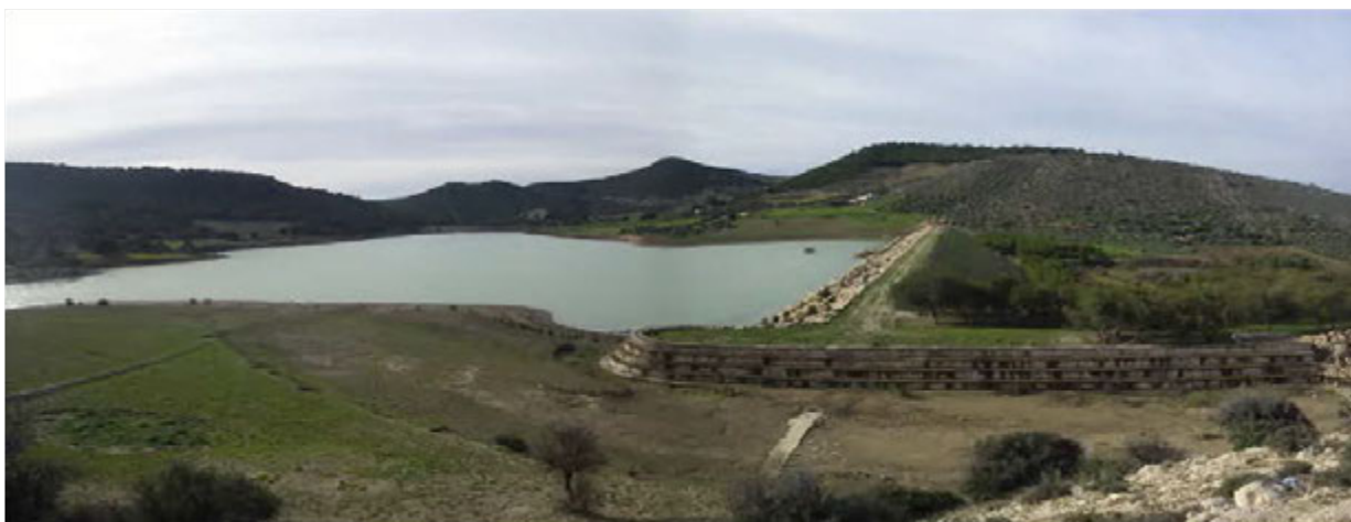
Vue d'ensemble depuis la rive droite. A l'avant, partie afflux du déversoir
