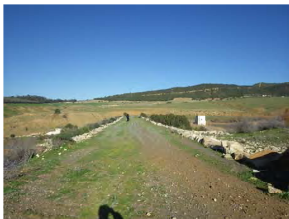
Crête du barrage
