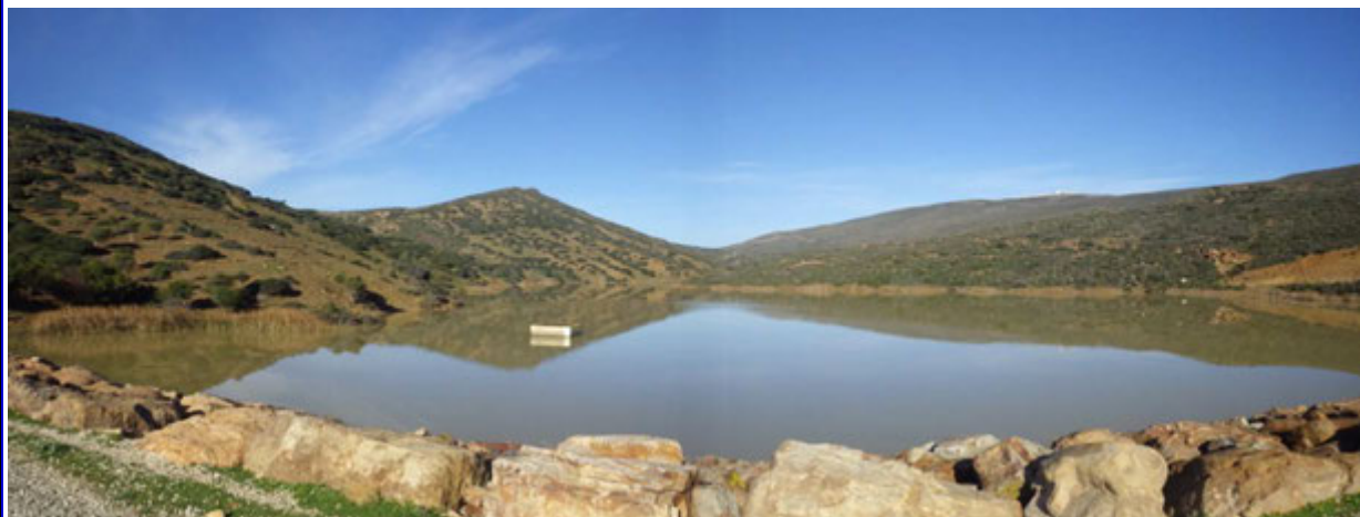
Vue d'ensemble du bassin de retenue. Tour de prise d'eau au centre-gauche.
