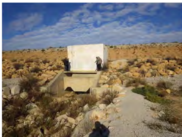
Ouvrage de décharge d'eau collectée
