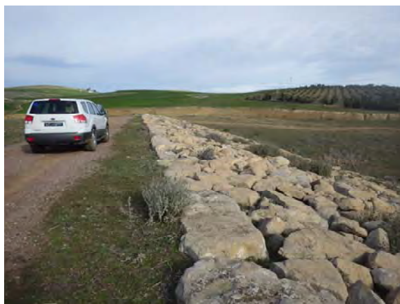
Partie en amont du barrage
