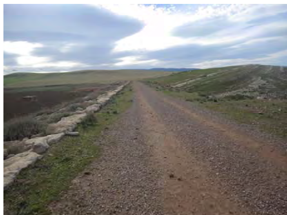
Crête du barrage
