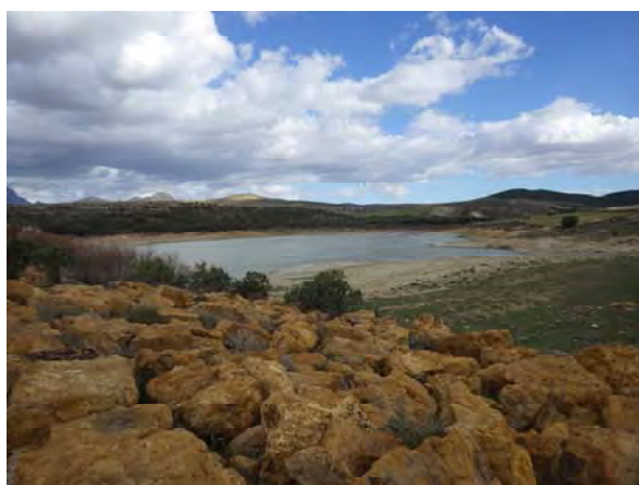
Partie afflux du déversoir
