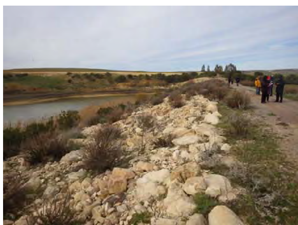
Partie en amont du barrage
