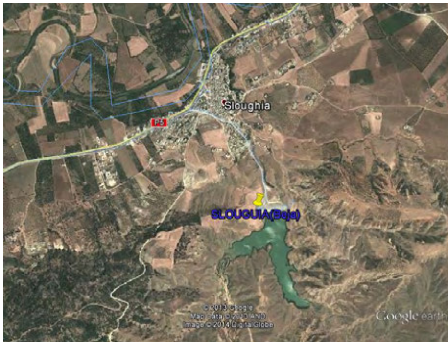
Figure 3.17 Relation entre le barrage de BE-3 Sloughia et la ville en aval
