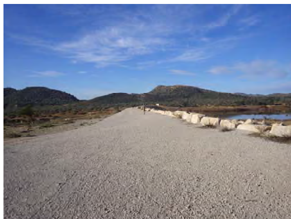
Crête du barrage
