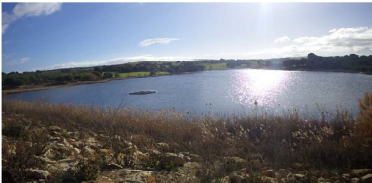
Vue d'ensemble du bassin de retenue. Niveau d'eau pratiquement plein
