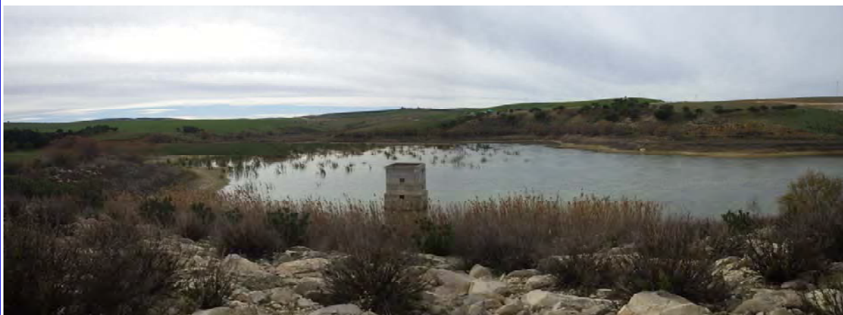
Vue d'ensemble du bassin de retenue. Tour de prise d'eau au centre. Niveau d'eau bas.
