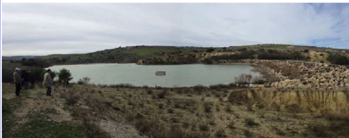
Vue d'ensemble du bassin de retenue, tour de prise d'eau au centre, barrage à droite. A l'avant, partie afflux du déversoir très érodée
