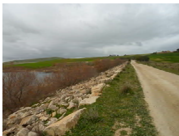
Crête du barrage
