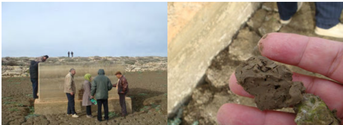
Figure 3.15 État d'envasement du bassin de la retenue de Seja (Siliana) (à gauche) et argile de la couche superficielle du sable entassé (à droite)
