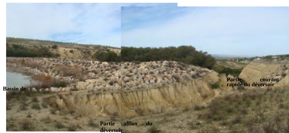
Figure 6.2 Partie afflux et partie à courant rapide (barrage de SI-4 Meskaya, gouvernorat de Siliana)
