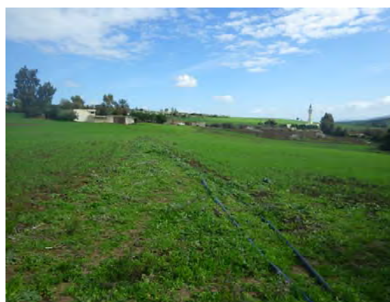
Périmètres directement en aval du barrage et canalisation
