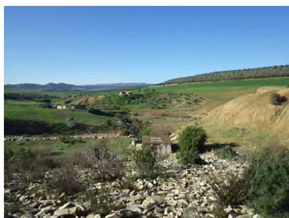
Partie en aval du barrage et ouvrage de décharge d'eau collectée
