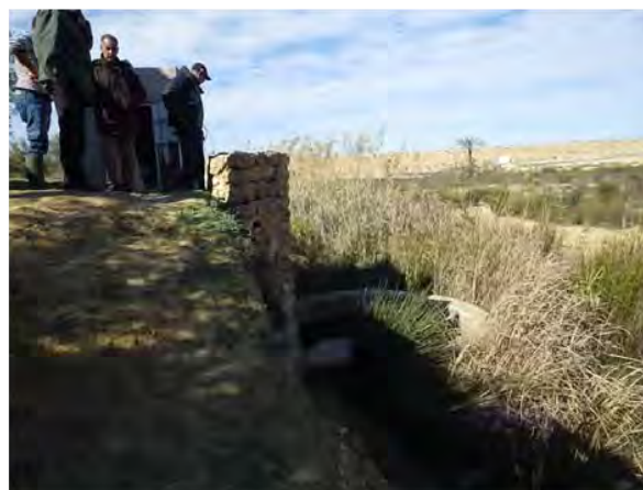
Station de pompage d'eau de ferme en aval
