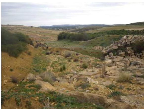
Partie courant rapide du déversoir
