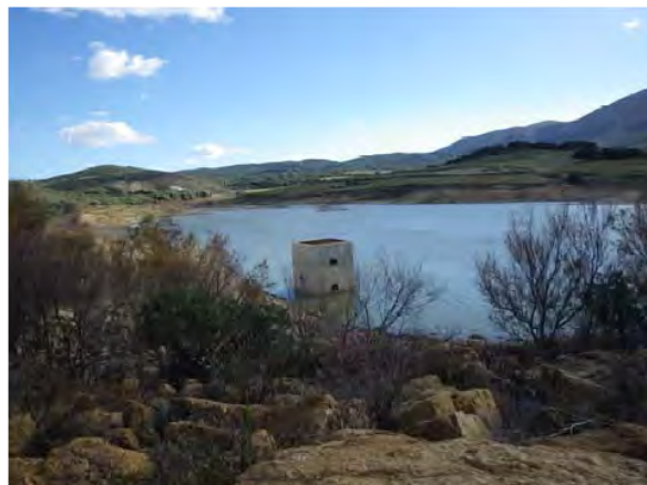
Bassin de retenue et ouvrage de prise d'eau
