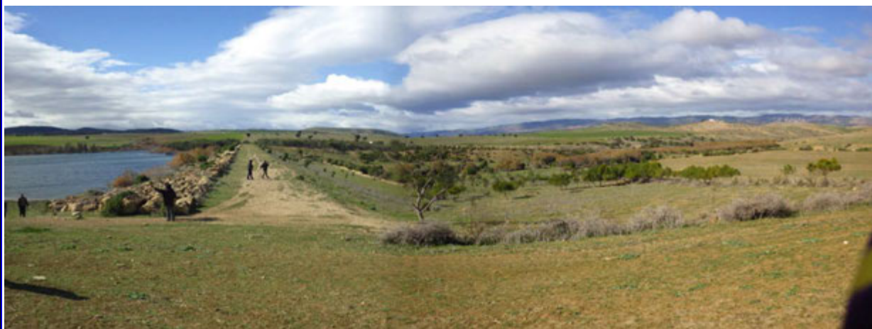
Crête du barrage vue depuis la rive droite du barrage et partie en aval du barrage
