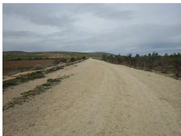
Crête du barrage
