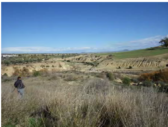
Partie en aval du barrage et salle de décharge d'eau collectée
