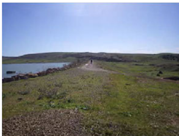
Crête du barrage. Bassin de régulation sur la colline d'en face
