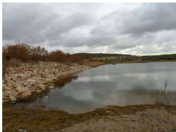
Partie en amont du barrage
