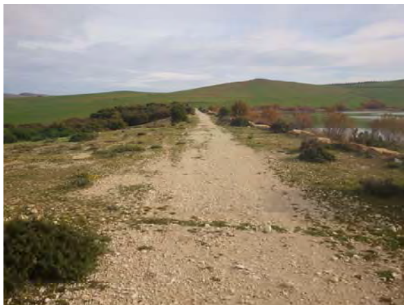
Crête du barrage
