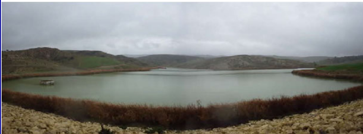
Vue d'ensemble du bassin de retenue. Tour de prise d'eau à gauche.
