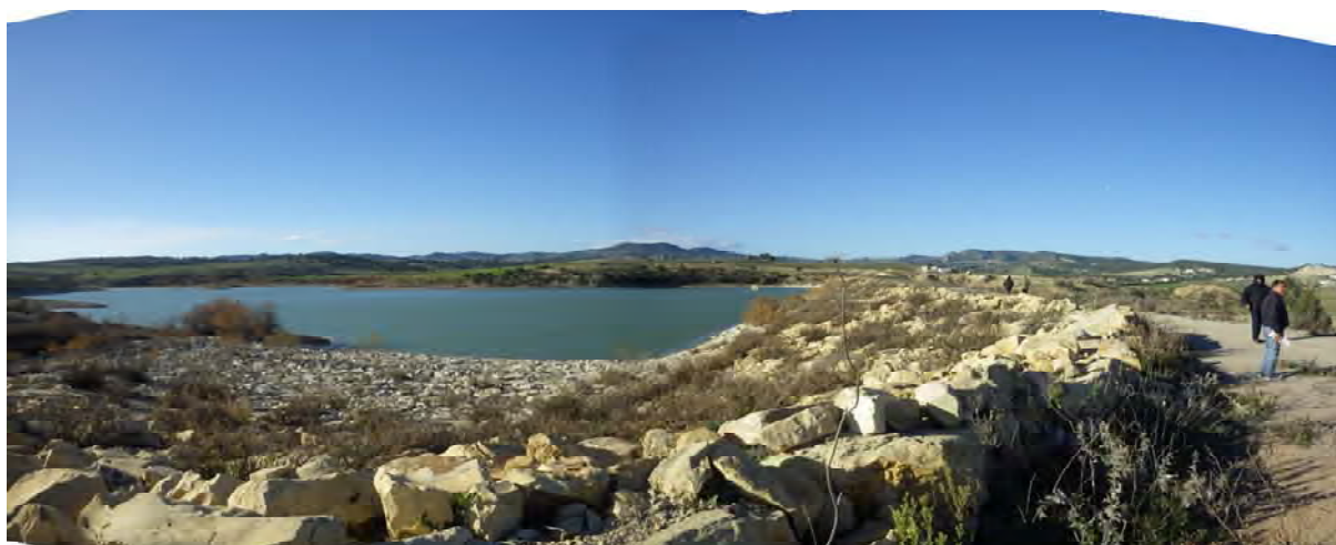
Partie en amont du barrage et bassin de retenue vus à partir de la rive droite
