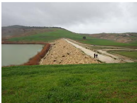
Partie en amont du barrage vue de la rive droite du barrage
