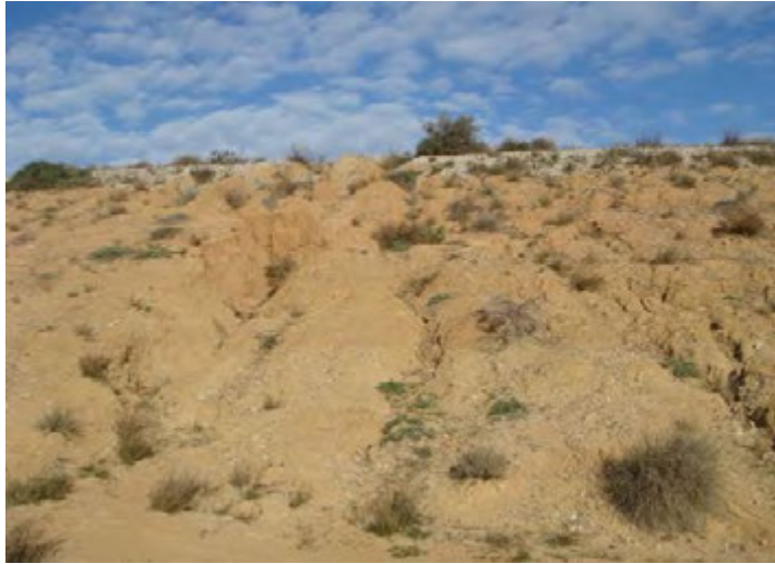
Figure 6.1 Érosion par les pluies de la pente en aval du barrage (barrage de SO-1 Breck)
