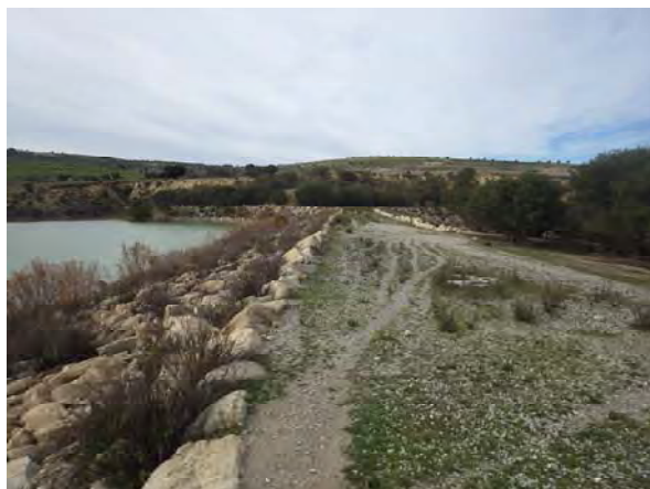
Crête du barrage
