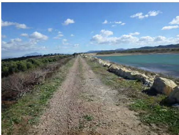
Crête du barrage, vue de la rive gauche à la rive droite
