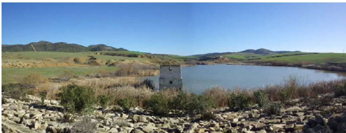
Vue d'ensemble du bassin de retenue. Tour de prise d'eau au centre. Niveau d'eau retenue bas.
