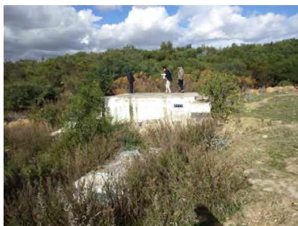
Ouvrage de décharge d'eau
