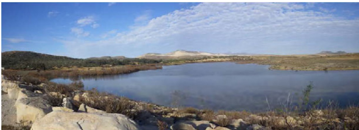
Vue d'ensemble du bassin de retenue
