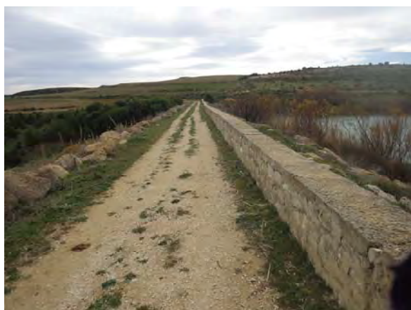
Crête du barrage
