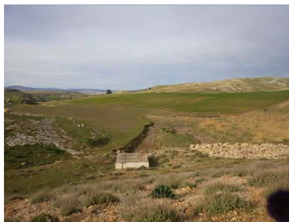
Partie en aval du barrage et ouvrage de décharge d'eau collectée
