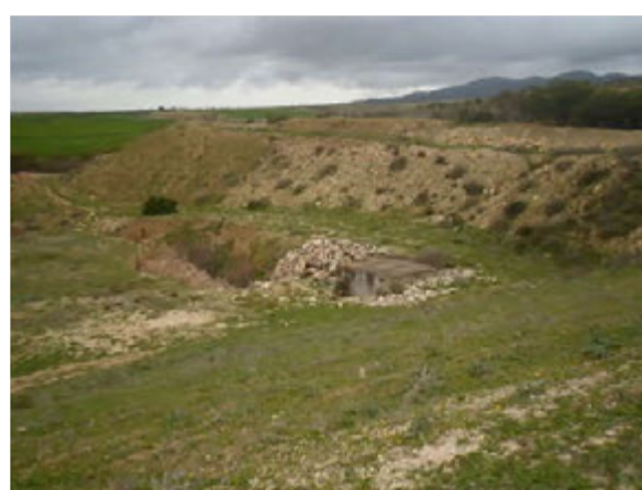
Ouvrage de décharge d'eau
