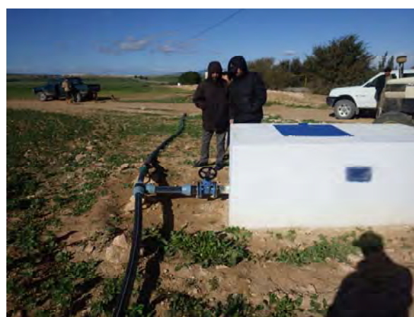
Canalisation aux environs des périmètres achevée en septembre 2013
