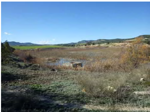
Bassin de retenue et tour de prise d'eau pratiquement ensablés, vus à partir de la rive droite
