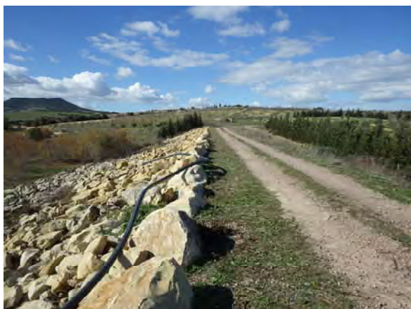
Partie en amont du barrage, canalisation, rive gauche
