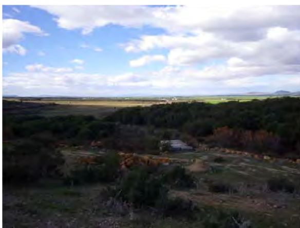
Ouvrage de décharge d'eau et partie en aval du barrage
