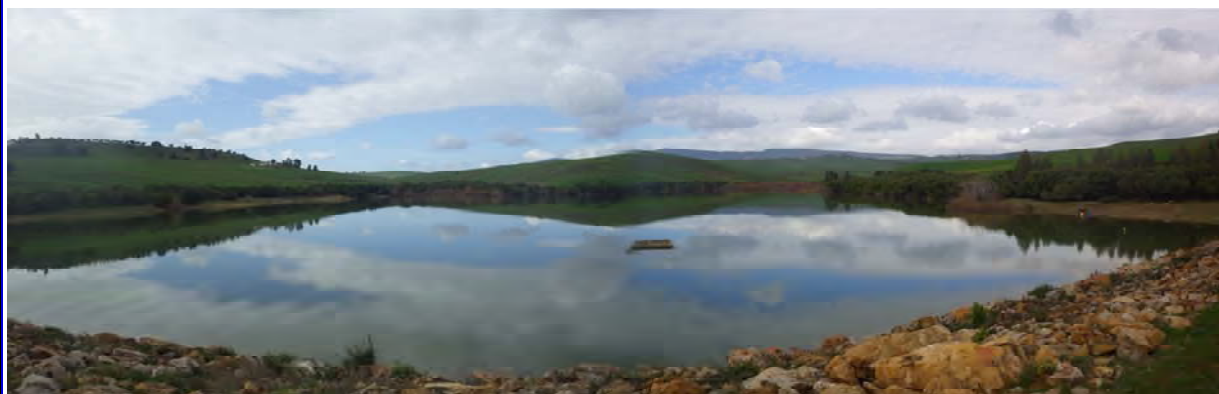
Vue d'ensemble du bassin de retenue. Sommet de la tour de prise d'eau au centre.
