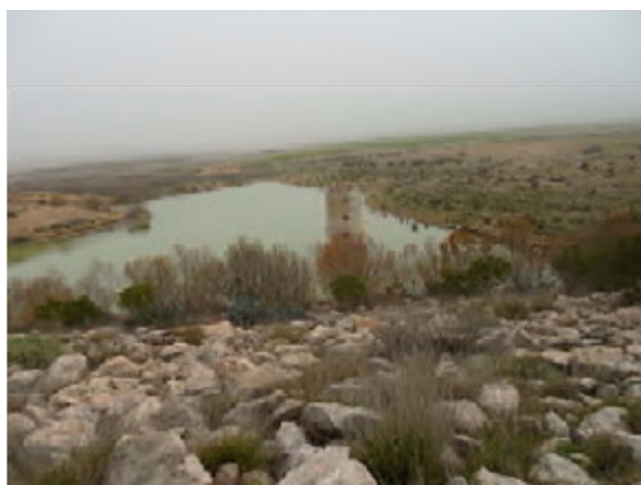
Tour de prise d'eau
