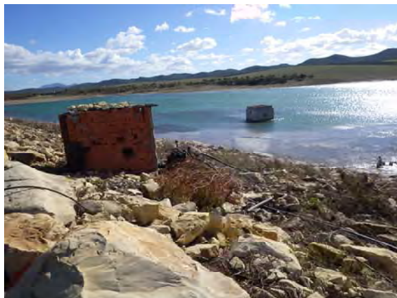
Bassin de retenue, pompe, tour de prise d'eau
