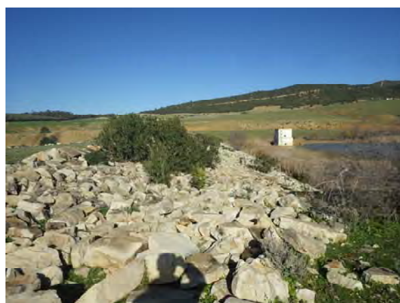
Partie en avant du barrage et tour de prise d'eau
