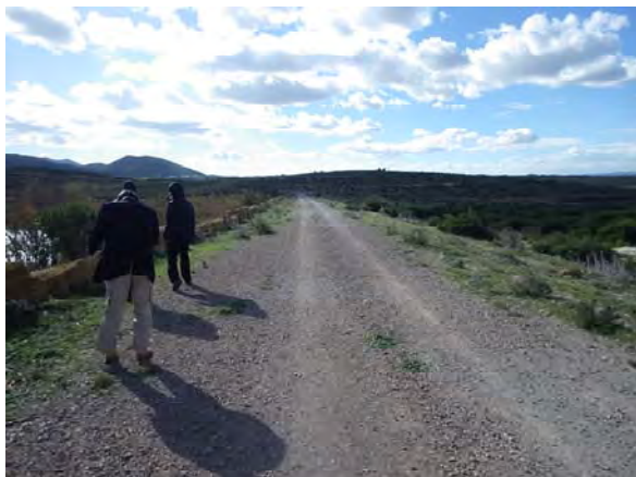
Crête du barrage
