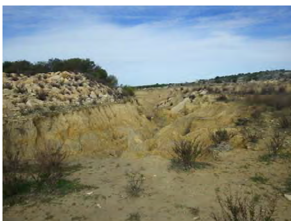
Partie courant rapide du déversoir
