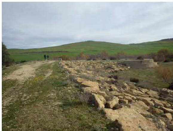
Partie en amont du barrage
