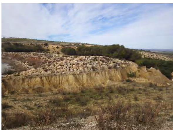
Canal latéral du déversoir
