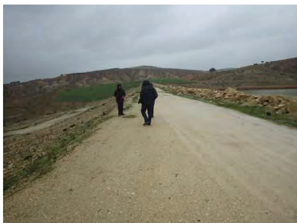
Crête du barrage
