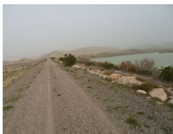
Crête du barrage
