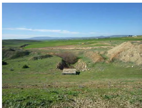
Ouvrage de décharge d'eau collectée
