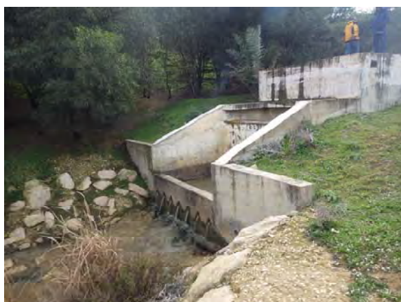
Ouvrage de décharge d'eau collectée
