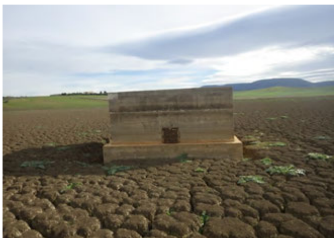
Figure 3.9 Bassin de retenue du barrage de Zaaroura (SI-6) complètement envasé (le 23 janvier 2014)
