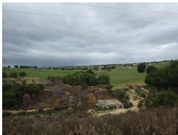
Ouvrage de décharge d'eau collectée
