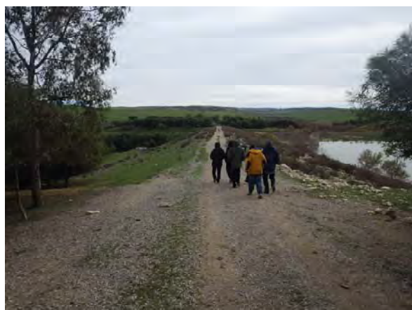
Crête du barrage
