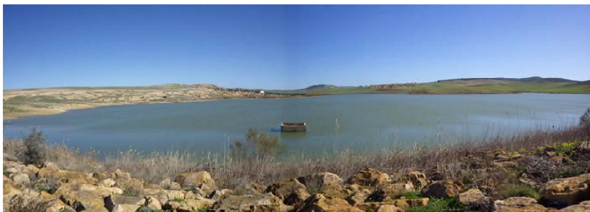
Vue d'ensemble du bassin de retenue
