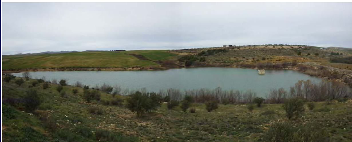
Vue d'ensemble du bassin de retenue. A droite, tour de prise d'eau et barrage.
