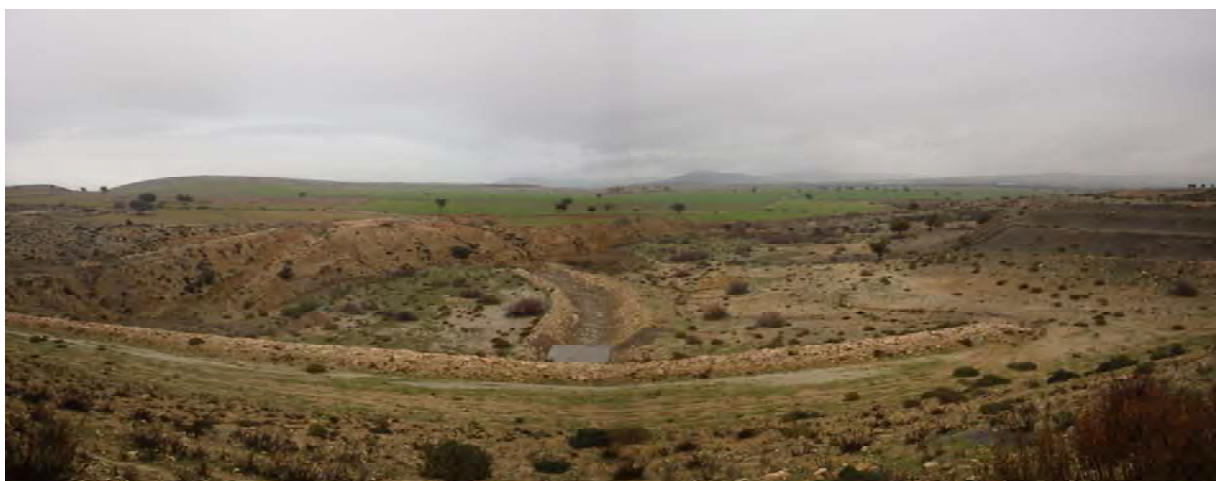
Ouvrage de décharge d'eau collectée et vue d'ensemble de la partie en aval du barrage
