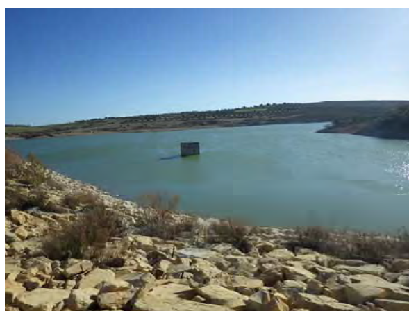
Bassin de retenue et tour de prise d'eau Des mesures contre l'érosion des sols sont prises aux environs du bassin de retenue.
