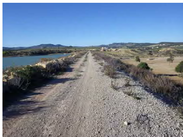
Crête du barrage, vue de la rive droite à la rive gauche
