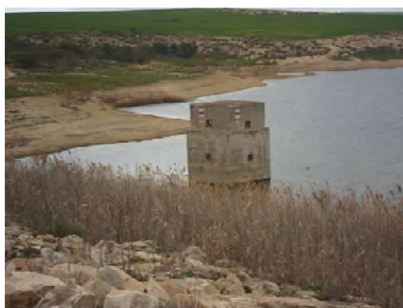
Tour de prise d'eau
