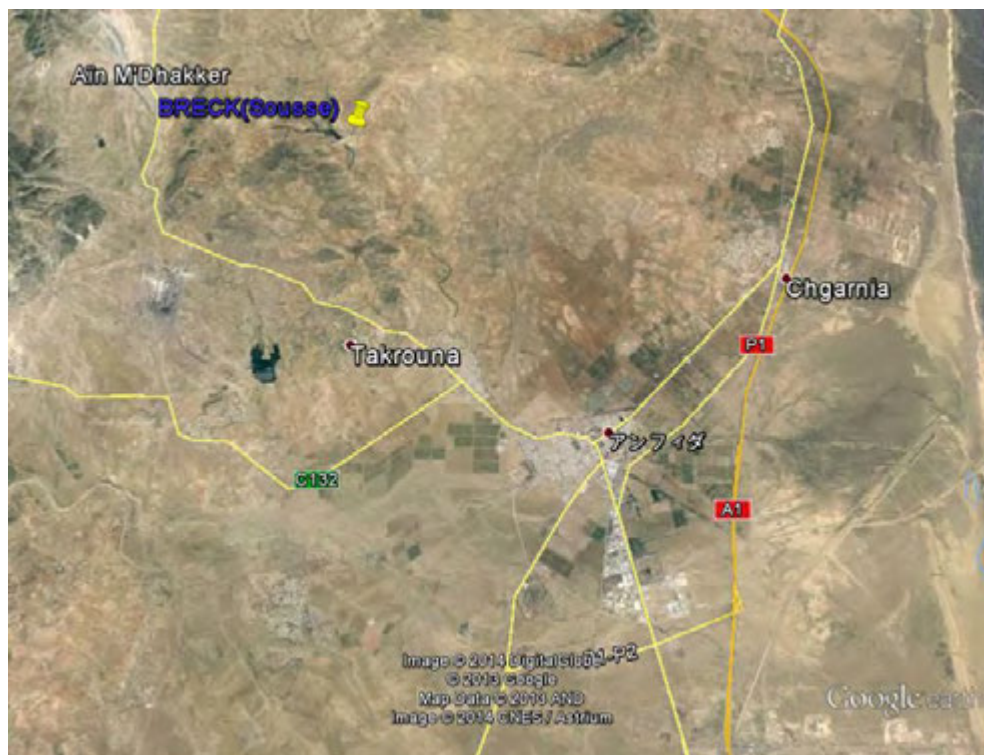
Figure 3.20 Relation entre le barrage de ZA-4 Gwissat et la ville en aval
