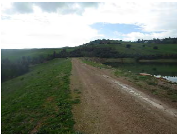
Crête du barrage
