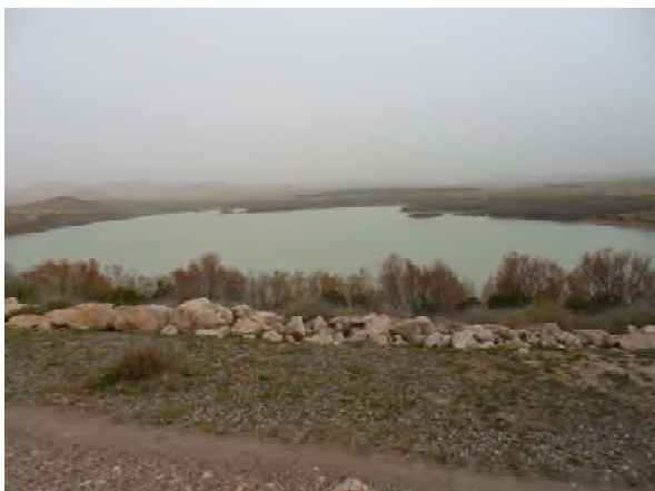
Vue d'ensemble du bassin de retenue
