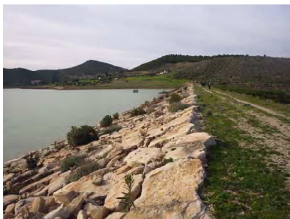
Partie en amont du barrage
