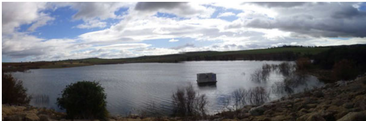
Vue d'ensemble du bassin de retenue
