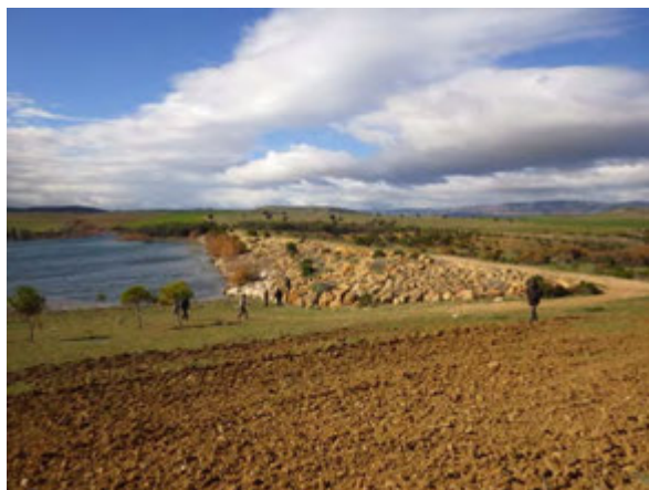
Partie en amont du barrage
