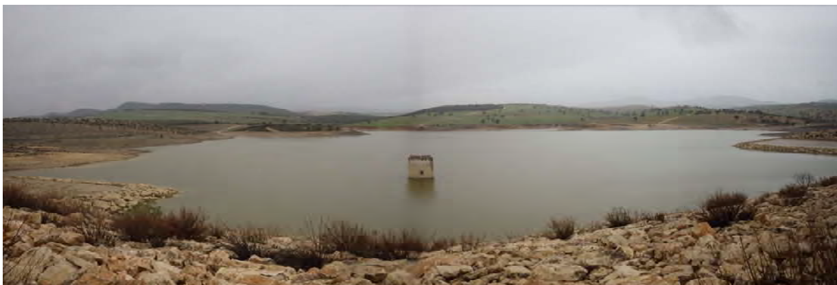
Vue d'ensemble du bassin de retenue
