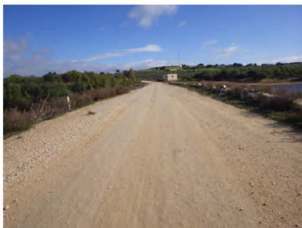
Crête du barrage
