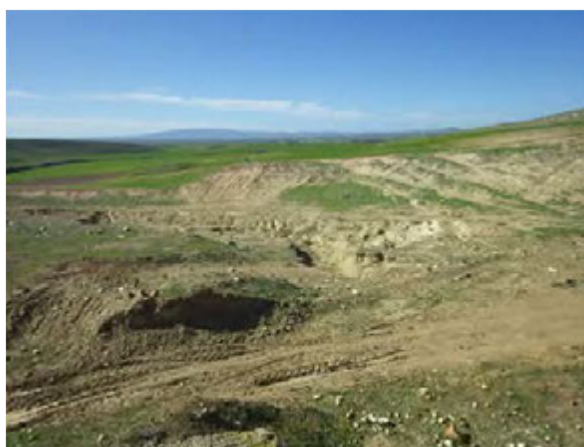
Partie en aval du courant rapide du déversoir
