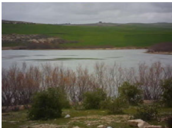
Vue d'ensemble du bassin de retenue
