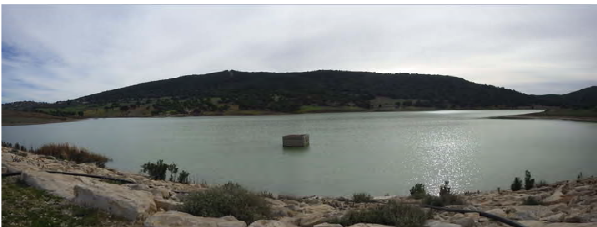
Vue d'ensemble du bassin de retenue et tour de prise d'eau. Tuyau de type siphon
