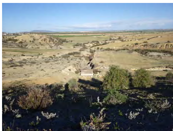
Ouvrage de décharge d'eau collectée et partie en aval du barrage
