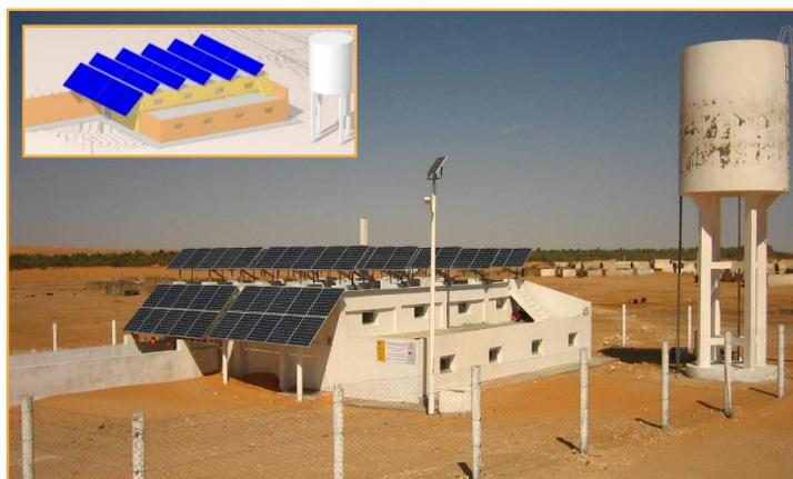
Projet d'approvisionnement en eau potable à partir d'une station de dessalement des eaux saumâtres d'un forage profond, en utilisant l'énergie solaire à Ksar Ghilène (CRDA de Kébili).
