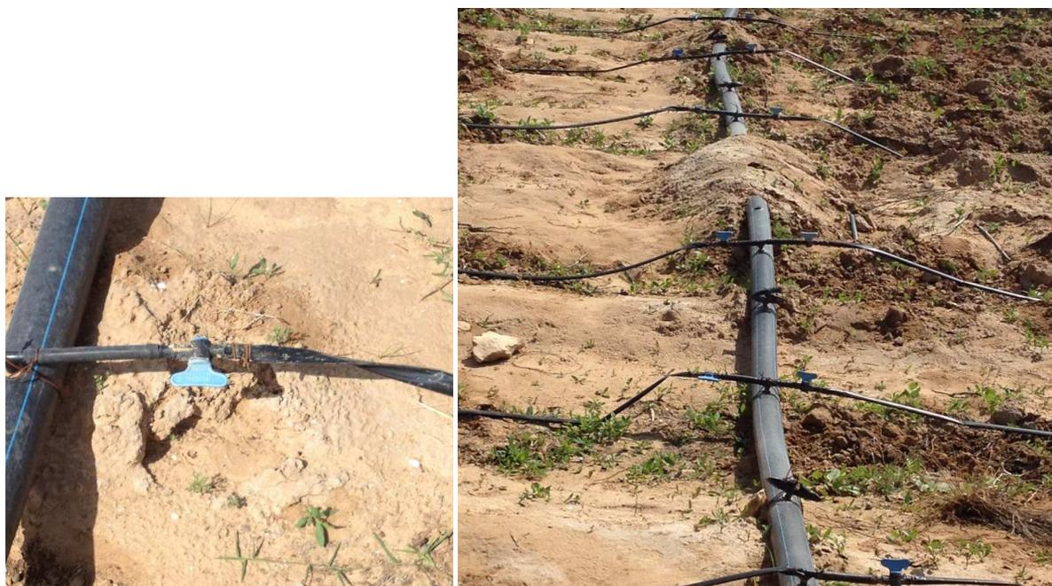
Photo 3 : vannettes installées au départ des goutteurs. Ce système devient rapidement ingérable.
