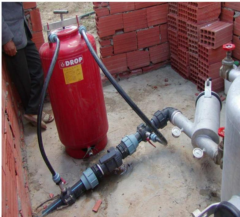
photo 5 : installation comprenant un injecteur d'engrais
